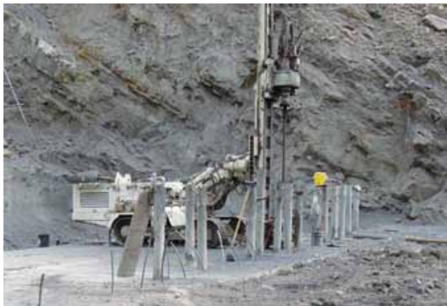
Foto 8 e 9 - Esecuzione dei micropali e armatura del plinto della pila 1
