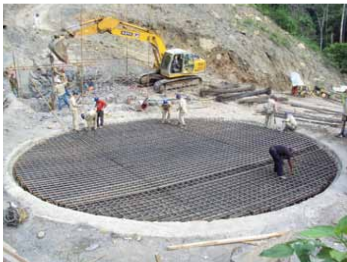
Foto 13 - Armatura di collegamento tra il pozzo e il plinto della Pila 2
