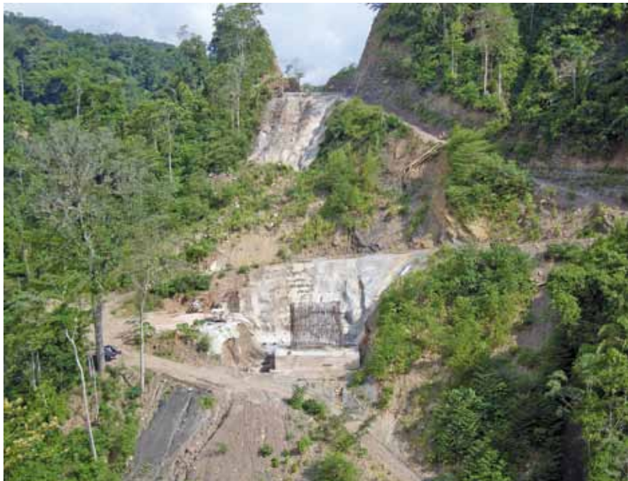
Foto 21 - Gli interventi di consolidamento sul versante sinistro; in alto le opere realizzate al di sotto della spalla sud e in basso il consolidamento degli scavi della pila 1
