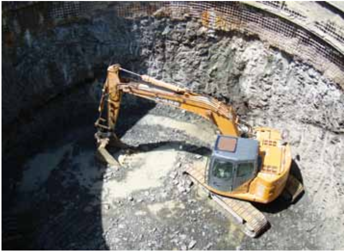
Foto 11 - Scavo del pozzo della Pila 2
