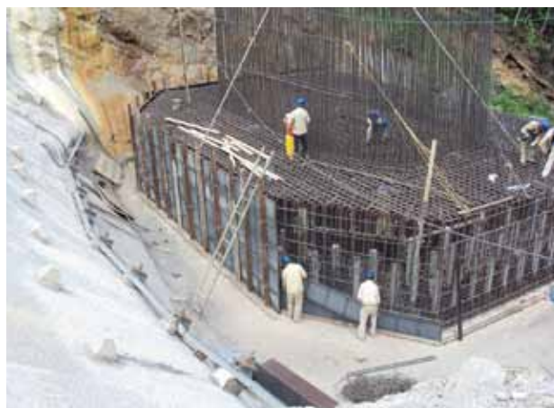
Foto 10 - Inizio della cassetteria del plinto e armatura dell'elevazione della pila 1 (si intravedono tra le armature i micropali di rinforzo)
