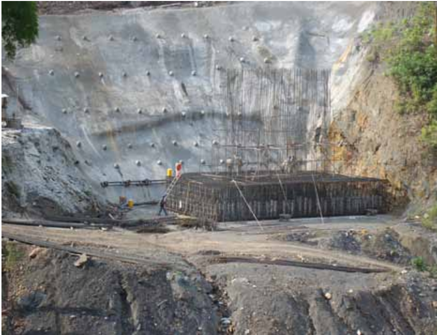
Foto 20 - L'intervento di tirantatura completato sugli scavi della pila 1
