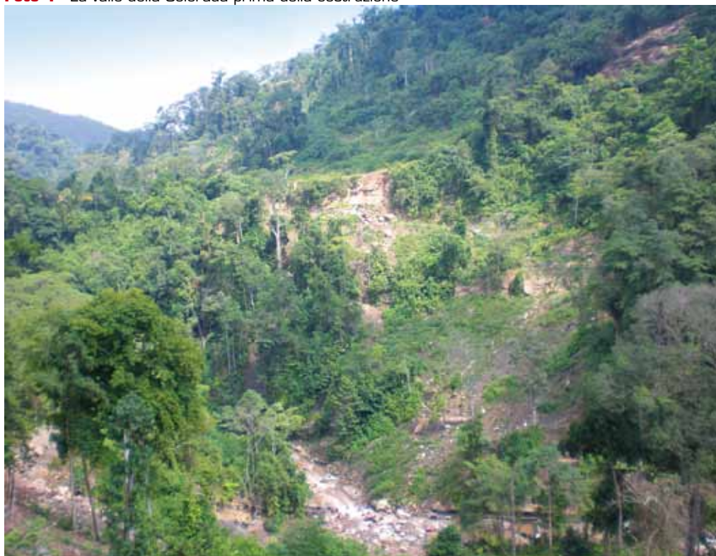
Foto 1 - La valle della Colorada prima della costruzione
