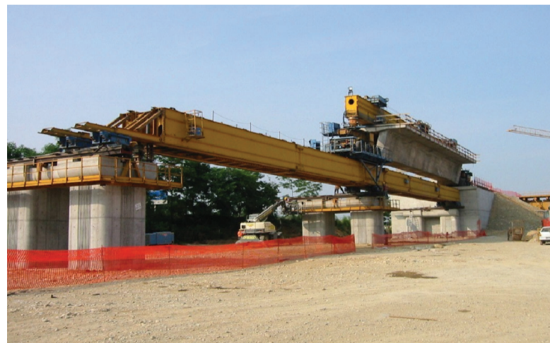
● Fig. 17 - Fase di varo. Massimo ingombro del sottoponte. ● Fig. 17 - Lowering the box beam onto the bearings.
