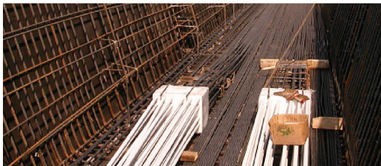
● Fig. 5 - Casette di inertizzazione e trefoli inguainati. ● Fig. 5 - Cutting-boxes and sheathed strands.
