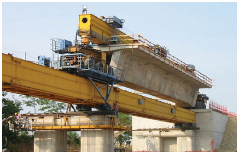
● Fig. 15 - Varo di un cassone. ● Fig. 15 - Launch of a half-deck.
