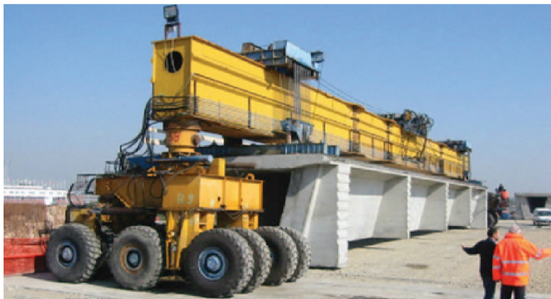
● Foto 14 - Movimentazione di un manufatto. ● Photo 14 - Handling a beam.
