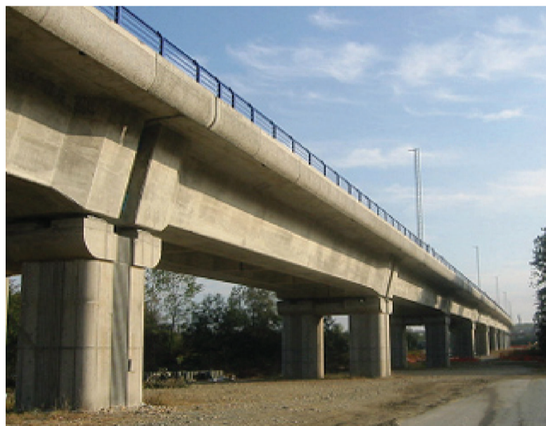
● Fig. 19 - Il viadotto finito a Chivasso. ● Fig. 19 - The finished viaduct.
