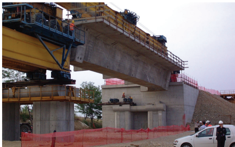
● Fig. 16 - Posizionamento del cassone sugli appoggi. ● Fig. 16 - Overview of the launching girder and dolly during launching.
