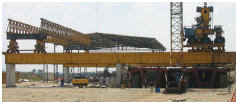
● Fig. 10 - L'impianto di prefabbricazione di Chivasso in fase di allestimento. ● Fig. 10 - The Chivasso precasting plant being set up.
