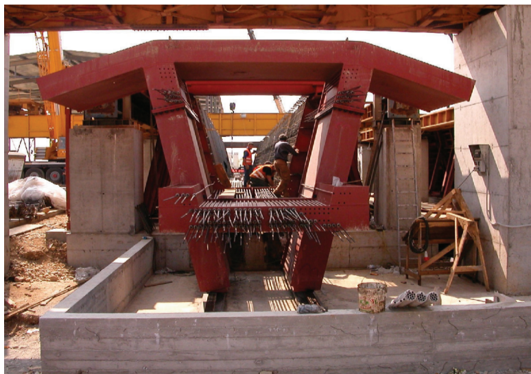
● Fig. 12 - Testata di tiro prima delle operazioni di tesatura. ● Fig. 12 - The beam tensioning end before tensioning.
