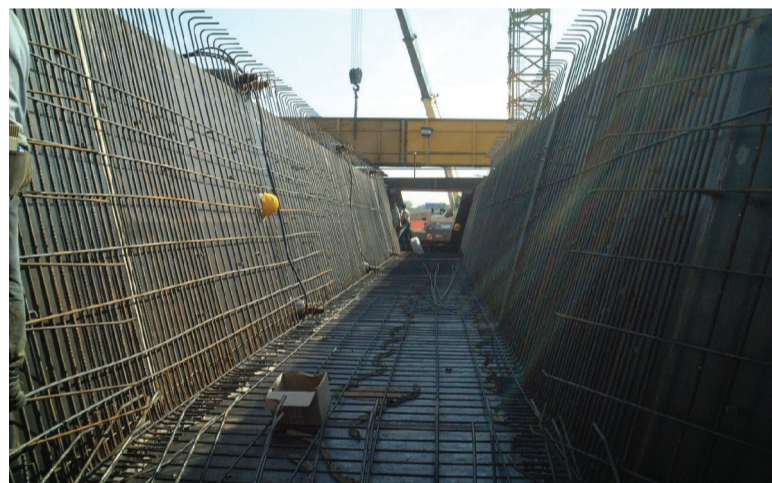
● Fig. 11 - Posizionamento della gabbia nel cassero. ● Fig. 11 - Positioning the reinforcing unit in the form.
